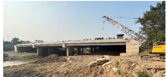
Hình 3.1.5-2. Cầu vượt sông Tích trên Quốc lộ 6 đang xây dựng
