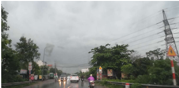
Hình 3.1.1-9. Quốc lộ 6 giao cắt với đường dây điện trên không 220 kV
