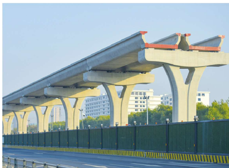
Hình 3.1.6-4. Ảnh thực tế phương án dầm dạng máng (dầm U)
