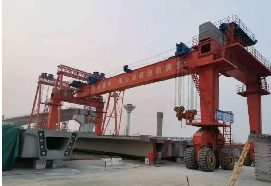
Hình 3.1.6-11. Công tác nâng và vận chuyển dầm bằng thiết bị nâng dầm bánh lốp trong bãi đúc dầm
