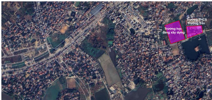
Hình 3.1.3-12. Ảnh vệ tinh hiện trạng đoạn S5 – S6
