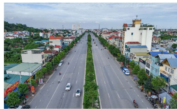
Hình 3.1.1-6. Đoạn Quốc lộ 6 đã hoàn thành cải tạo, mở rộng
