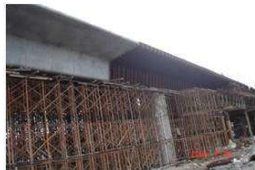
Hình 3.1.6-7. Ảnh thực tế thi công phương pháp đổ bê tông tại chỗ bằng hệ giàn giáo
