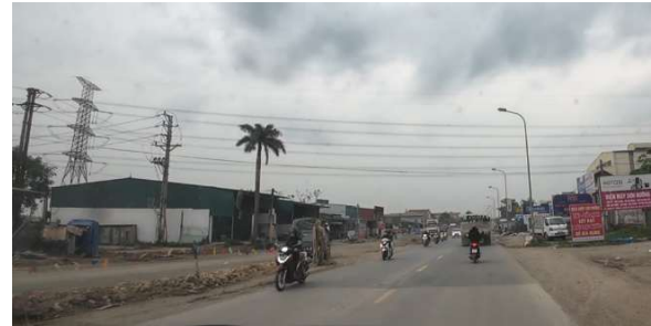
Hình 3.1.1-10. Quốc lộ 6 giao cắt với đường dây điện trên không 500 kV
