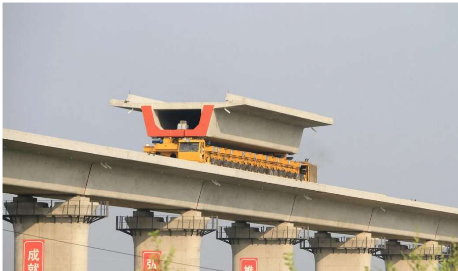
Hình 3.1.6-12. Vận chuyển dầm hộp trên cầu
