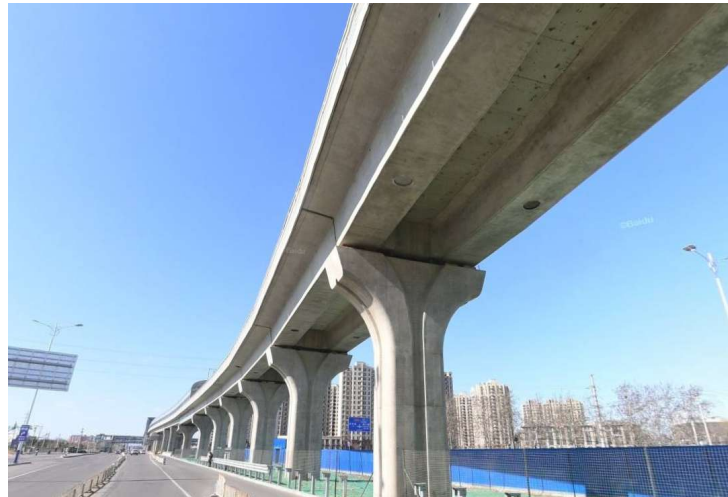
Hình 3.1.6-3. Ảnh thực tế phương án dầm hộp nhỏ
