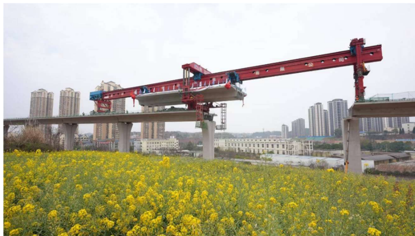
Hình 3.1.6-8. Ảnh thực tế thi công phương pháp lắp dựng cả nhịp bằng cầu kiện dầm đúc sẵn
