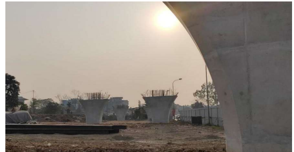
Hình 3.1.1-4. Ảnh hiện trạng thi công nút giao khác mức giữa đường VĐ 4 và QL6
