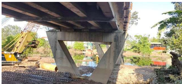
Hình 3.1.5-1. Cầu Mai Lĩnh hiện trạng
