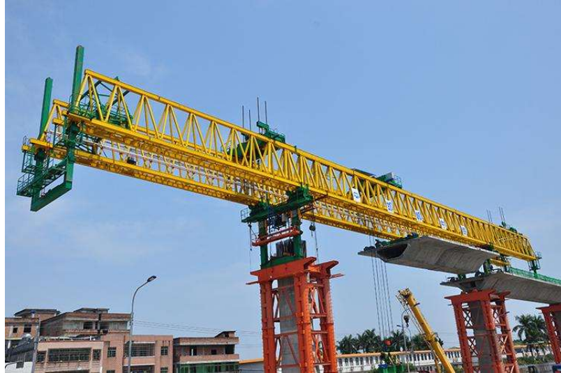
Hình 3.1.6-9. Ảnh thực tế thi công phương pháp lắp ghép đốt dầm đúc sẵn
