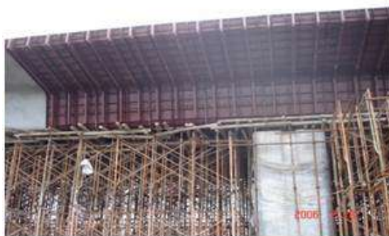
Hình 3.1.6-7. Ảnh thực tế thi công phương pháp đổ bê tông tại chỗ bằng hệ giàn giáo
