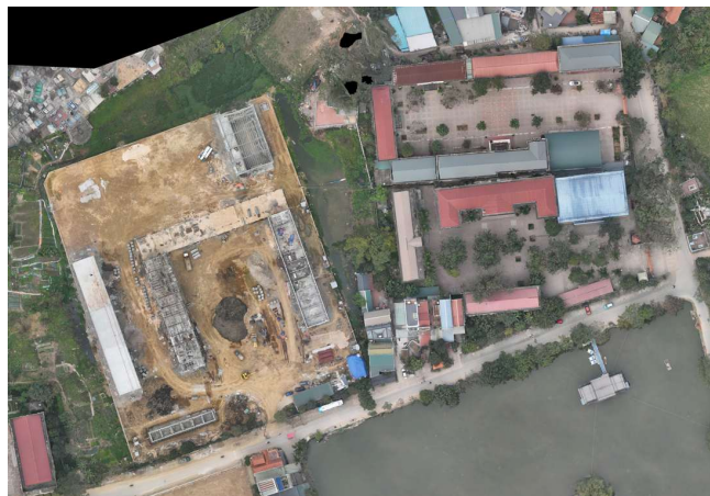
Hình 3.1.3-13. Ảnh vệ tinh hiện trạng đoạn S5 – S6
